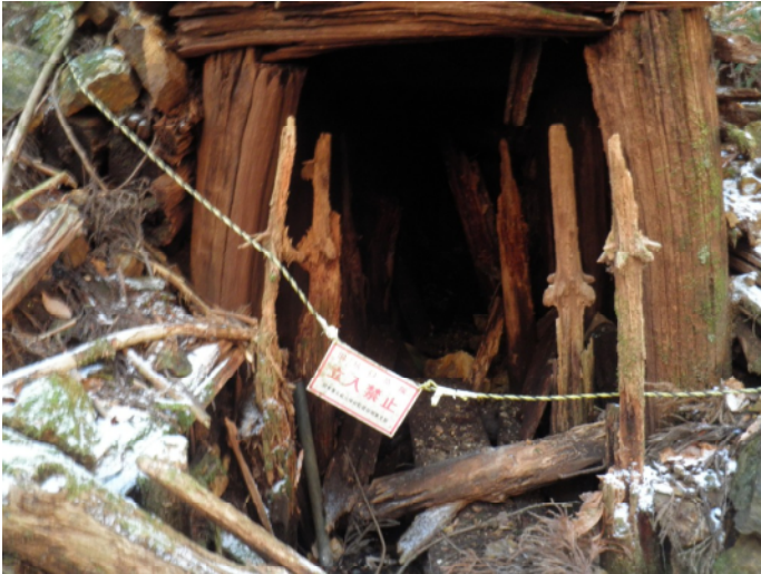
写真5 坑口の接近写真
