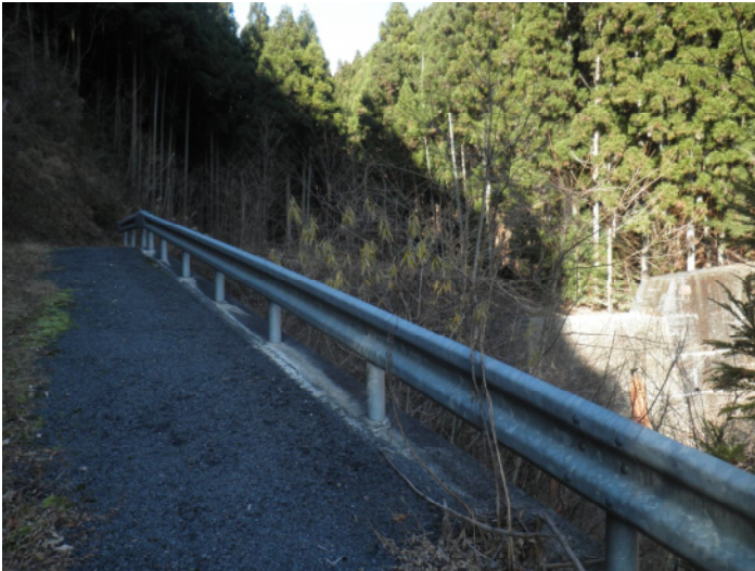
写真2 汲井戸沢の砂防ダム。
