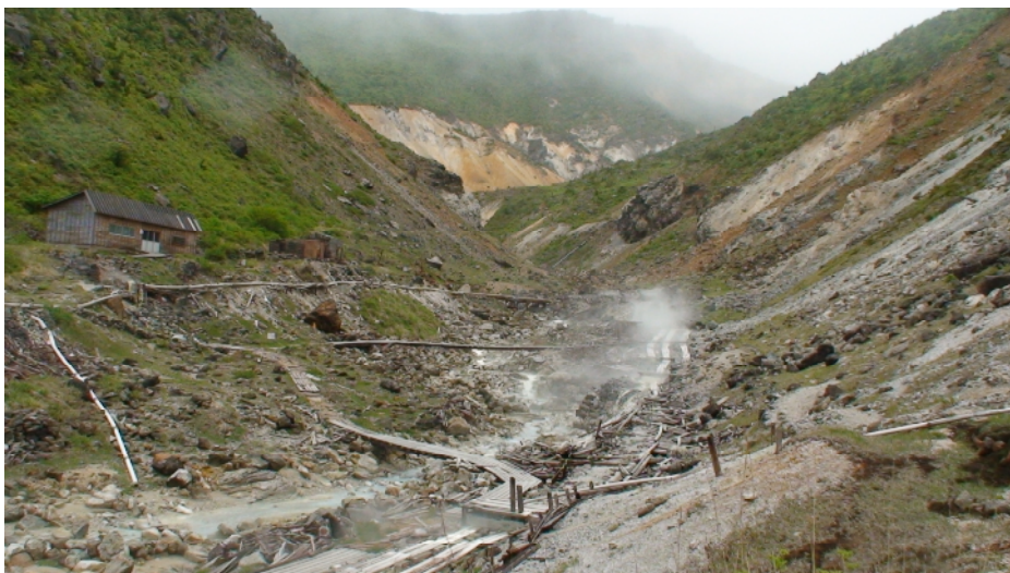
左の建物は湯ノ花採取業者の飯場らしい。その少し右に、完全に朽ち果てた廃屋がある。中央付近の白煙は源泉の湯気である。湯気の右手の斜面が産地。
